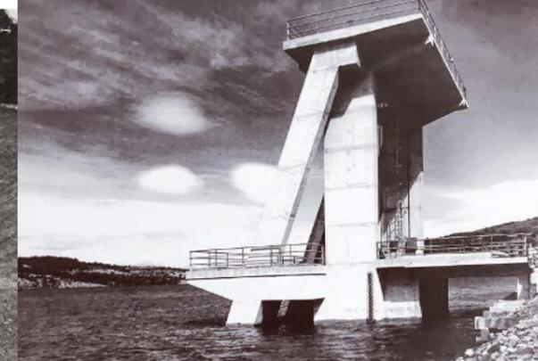
Photo de la prise d'eau à sa mise en service. Seul environ 10 mètres de cet édifice sont visibles sur les 32 mètres.
